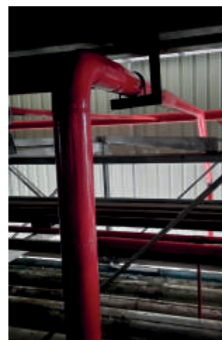
MONTAGEM DE TUBULAÇÕES DE HIDRANTE E SPRINKLER / ASSEMBLY OF HYDRANT AND SPRINKLER PIPING
