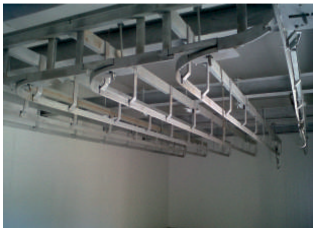
FABRICAÇÃO E MONTAGEM DE TRILHAMENTO / RAIL MANUFACTURING ASSEMBLY
