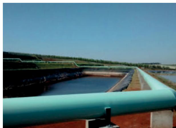
MONTAGEM TUBULAÇÃO CAPTAÇÃO DE ÁGUA / WATER PIPE LINES
