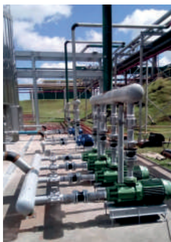
MONTAGEM DE BOMBAS UTILIDADES / PUMP PIPE LINES
